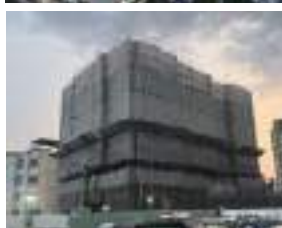
工地施工架帆布圍籬鋪設
