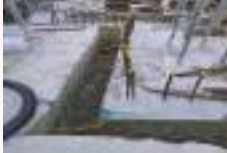
鋪面與結構體之縫隙防護網
