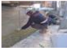
鋪面與結構體之縫隙防護網
