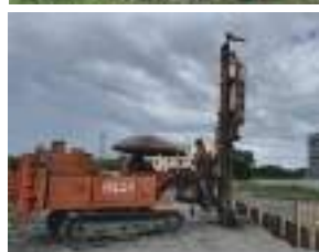
工地鋼軌樁鑽堡機施工
