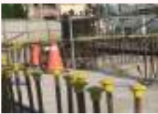
鋼筋裸露防護
